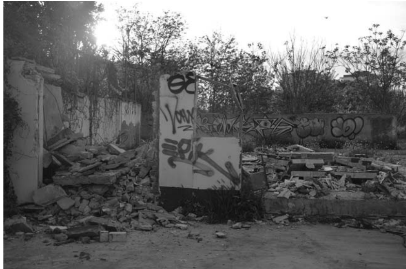
Εικόνα 2. Κατεδάφιση κτιρίου στην οδό Κωλέττη. Φωτογραφία: Νίκος Βράντσης
