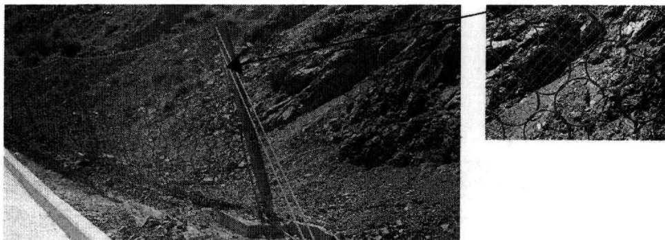
Σχήμα 11. Ελαστικός μεταλλικός φράχτης τοποθετημένος σε θέση της Εθνικής οδού Μηλίας-Μετσόβου
