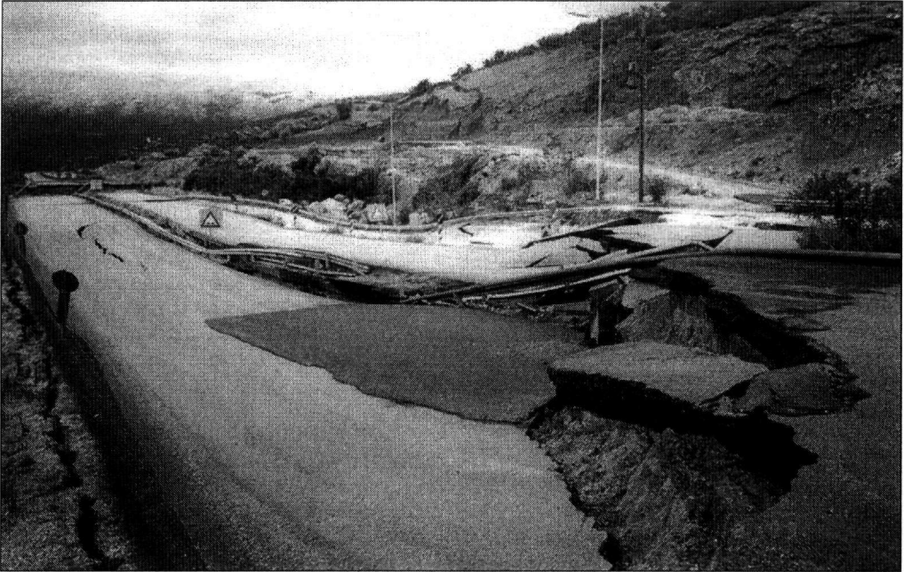
Σχήμα 5. Άποψη του βυθίσματος που προκάλεσε η κατολίσθηση στο οδόστρωμα της Ε.Ο. Κορίνθου-Τρίπολης.
