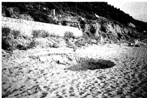
Σχήμα 10α. Πευκούλια: Κρατήρας διαμέτρου 3m και βάθους 2m
