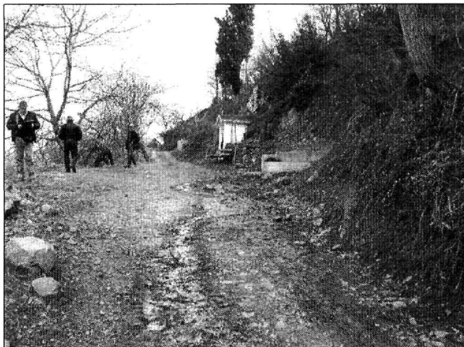
Σχήμα 2. Μικροπηγή εντός του χώρου του οικισμού των Καναλιών. Διακρίνεται η ανεξέλεγκτη ροή των νερών που εμποτίζουν συνεχώς τα εδαφικά υλικά.
