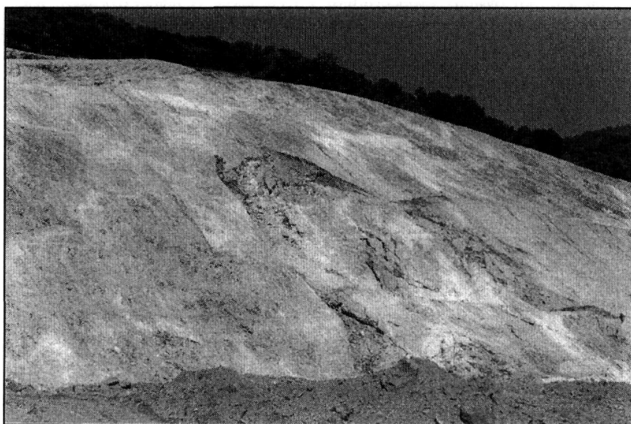
Σχήμα 3. Κατολίσθηση αναβαθμιδών το Μάρτιο του 2002.
