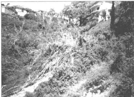
Φωτ. 2. Άποψη της κατολίσθησης στο Α/κό πρανές του κεντρικού ρέματος (2 η θέση).
