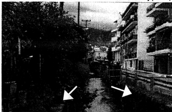
Εικόνα 1. Άποψη του μεσαίου τμήματος του χείμαρρου Διακονιάρης που φαίνεται ο εγκιβωτισμός το στένεμα (βέλη) και η οικοπεδοποίηση της κοίτης του.
