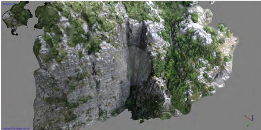
Εικόνα 2. Παράδειγμα 3D μοντέλου αρχόμενης διάβρωσης στη ζώνη ενός ρήγματος στη θέση Μπελόη, στο βόρειο χείλος της Χαράδρας
