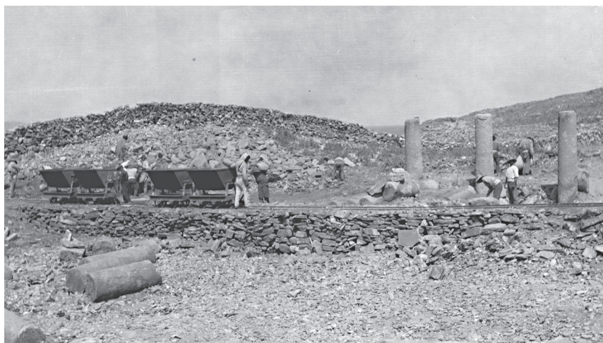
Figure 3. Photo from the excavation works of the Granite Palaistra, where workmen are using a Decauville railway and wagons. Jean-Charles Moretti, Δήλος 1873–1913: Εικόνες μιας αρχαίας πόλης που έφερε στο φως η ανασκαφή (Athens: Melissa, 2017), 152, photo 131. EFA photographic archive.
