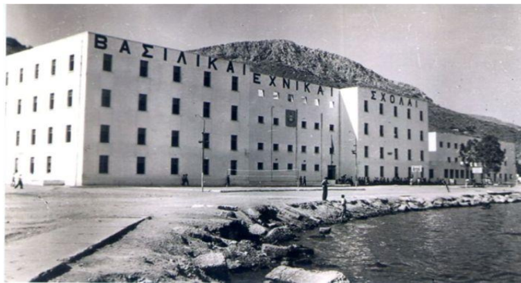
Εικόνα 1: Η Γκαζέρμα Σομερτζίμπιλι (Caserma Sommergebili – Στρατώνας Πληρωμάτων Υποβρυχίων) μετατρέπεται σε βασικό κορμό των εργαστηρίων των Βασιλικών Σχολών.
