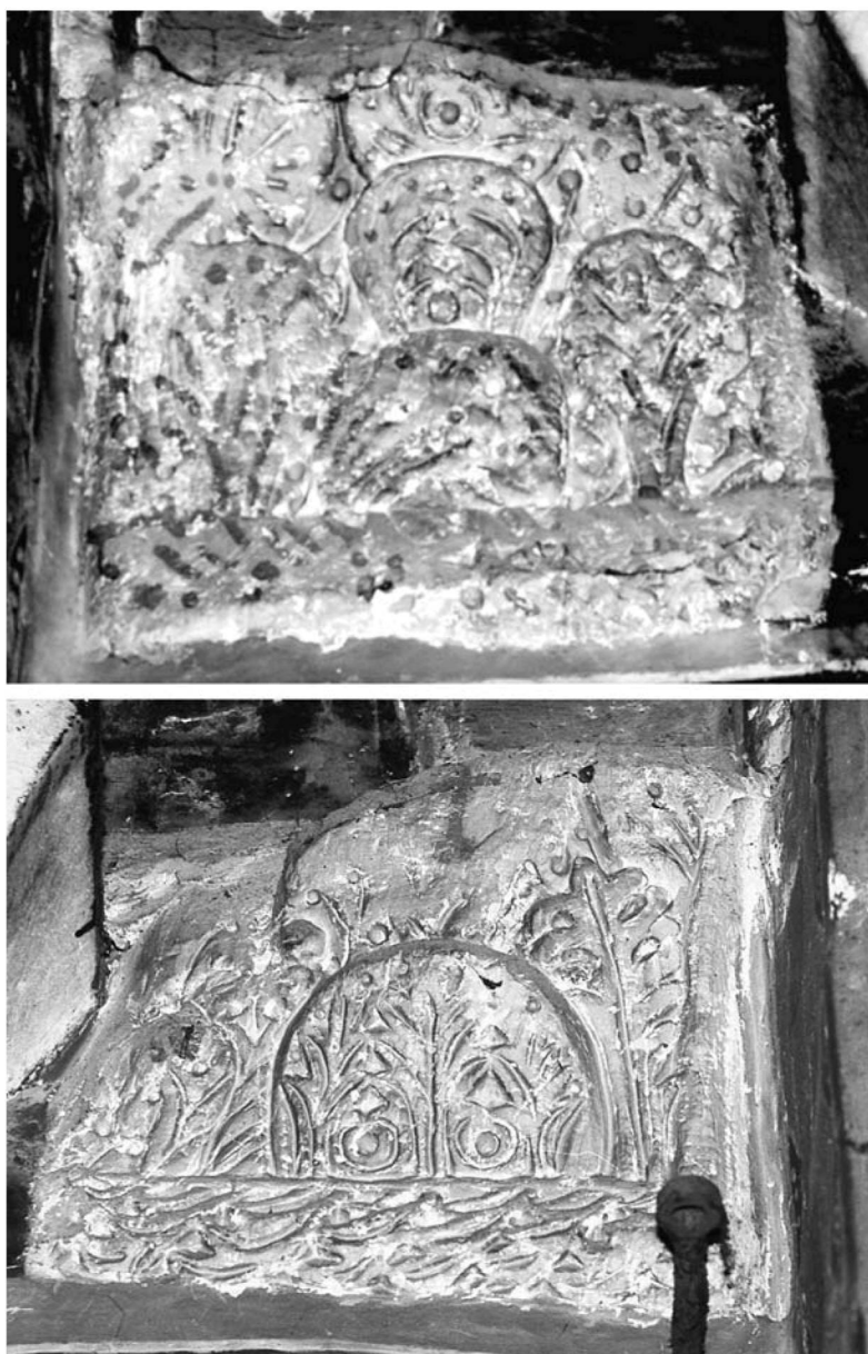
Εικ. 8-9. Τα γύψινα επίκρανα πάνω στα οποία στηρίζονται τα ακραία τεταροκνυκλικά τόξα.
