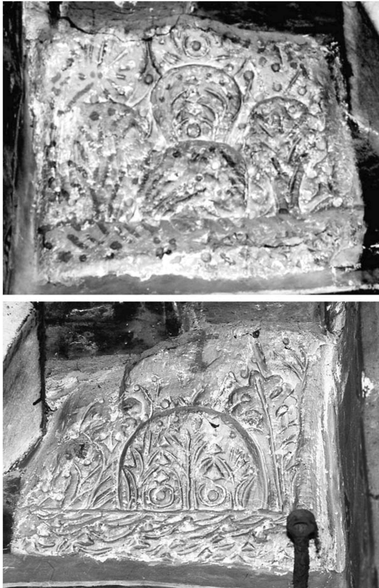
Εικ. 8-9. Τα γύψινα επίγραμμα πάνω στα οποία στηρίζονται τα ακραία τεταρογωνκλικά τόξα.
