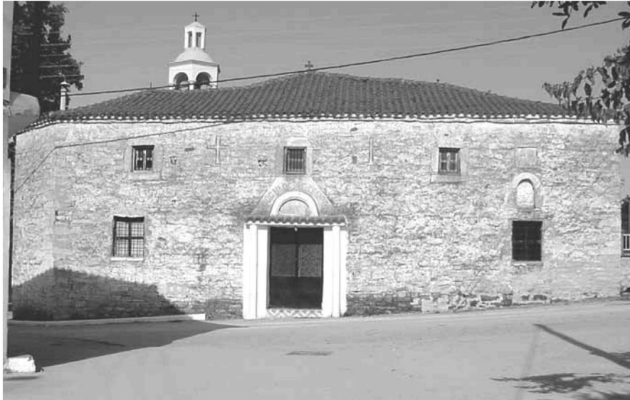
Εικ. 7. Γενική άποψη δυτικής πλευράς. General view of western side.
