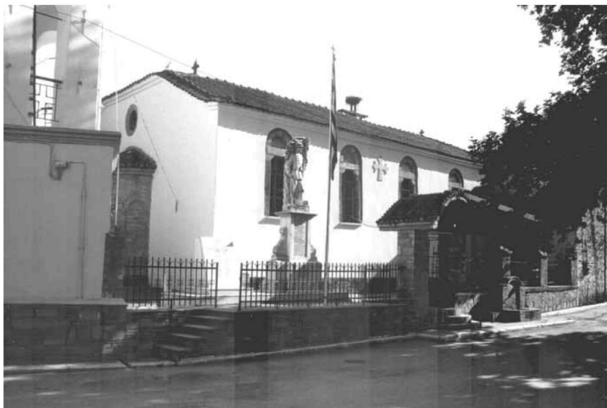
Εικ. 1. Γενική άποψη του ναού από ΒΑ. General view of the church from north-eastern.
