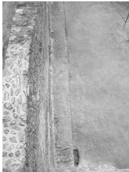
Εικ. 4. Το μεταπύργιο μεταξύ των πύργων Π12-Π11. Ph. 4. La partie des remparts entre la tour no 12 et la tour no 11.
