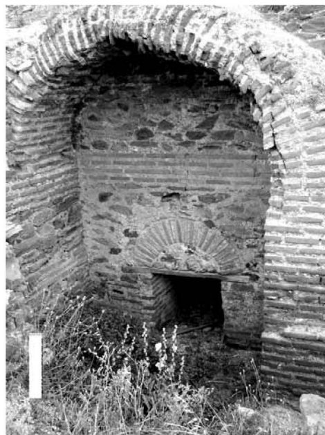
Εικ. 12. Η εσωτερική πύλη του πύργου Π13.
