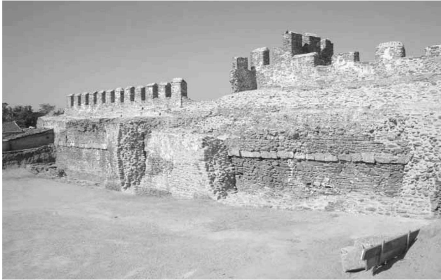
Εικ. 1. Βόρειο τείχος Θεσσαλονίκης. Το τμήμα μεταξύ των πύργων Π14-Π15 δυτικά του κόμβου της ακρόπολης.
