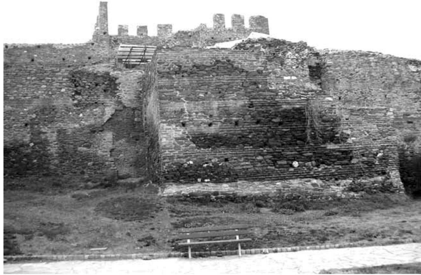
Εικ. 11. Κομνηνός πύργος Π13. Η φραγμένη πύλη και η πυργοειδής κατασκευή σχήματος «πει».
