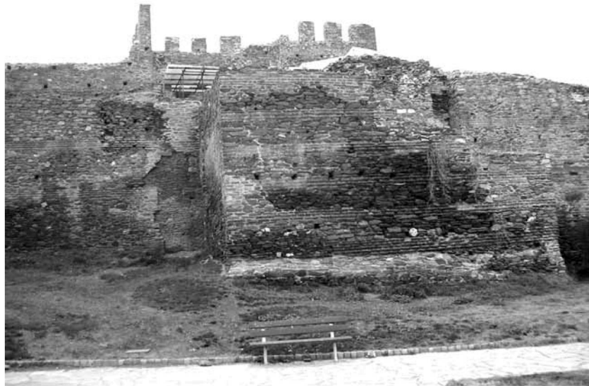
Εικ. 11. Κομνηνικός πύργος Π13. Η φραγμένη πύλη και η πυργοειδής κατασκευή σχήματος «πει».
