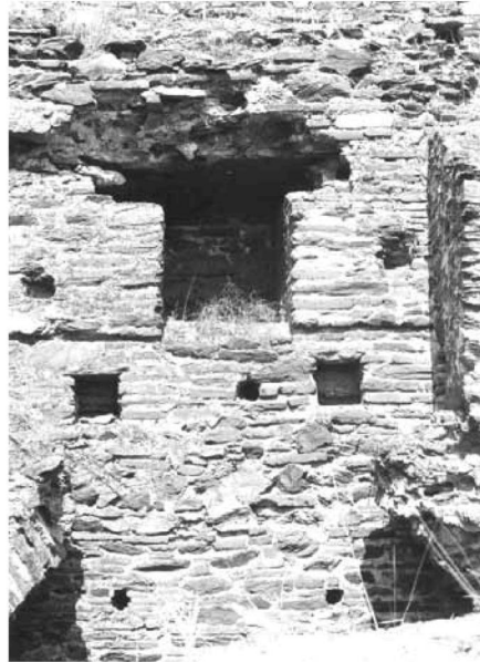
Εικ. 10. Τοιχοποιία κομβικού πύργου Π13. Υποδοχές του μηχανισμού τον «καταράκτη» της πύλης. Ph. 10. Maçonnerie de la tour no 13. Récepteurs du mécanisme de la clôture de la porte (saracinesca).
