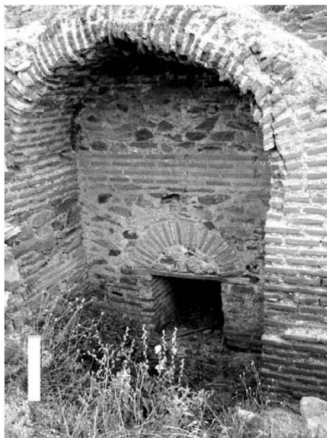
Εικ. 12. Η εσωτερική πύλη του πύργου Π13.
