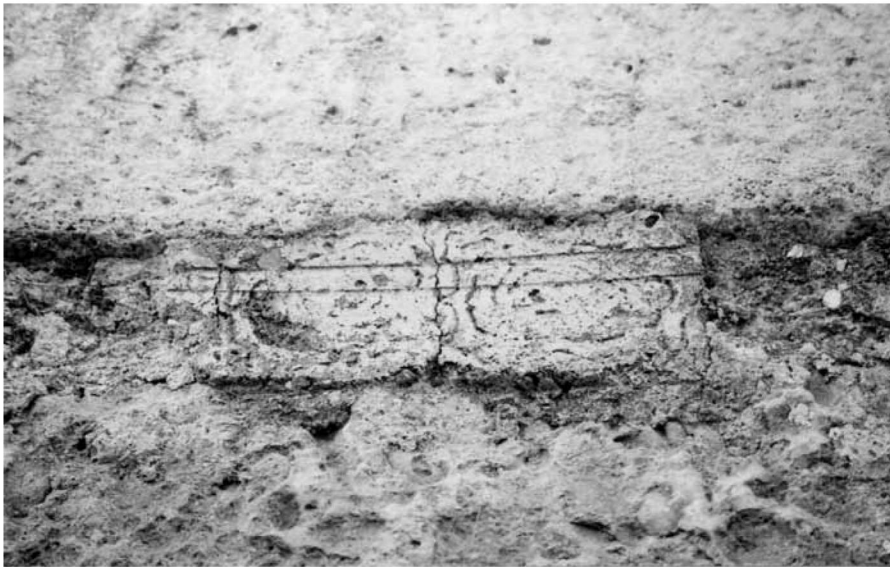
Εικ. 2. Βόρεια όψη πύργου Π16. Διακοσμητικά μυστρίσματα.
