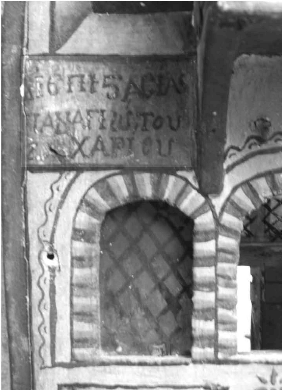
Εικ. 10. Ξύλινο πρόπλασμα κτηρίου (1795). Αφιερωματική επιγραφή (λεπτομέρεια).
