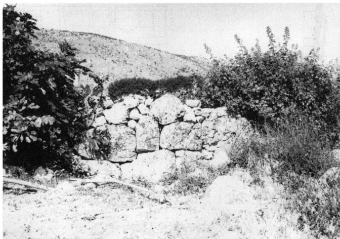
Εικ. 5. Ανατολική όψη του τείχους στο ψηλότερα διατηρούμενο τμήμα του.
