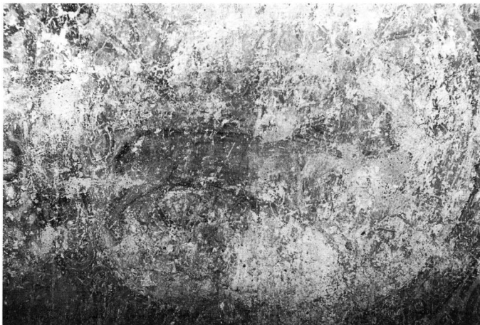
Εικ. 19. Σισάνι, νότιο κλίτος, νότιος τοίχος, γ' φάση. Διακοσμητικό θέμα με λέοντα(;) σε μέταλλο.
