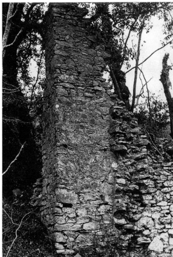
Εικ. 4. Αποψη της ΝΑ. γωνίας με τις ημικατεστραμμένες αβαθείς αντηρίδες (1990).
