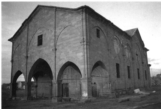
Εικ. 25. Άγιοι Θεόδωροι Μαλακοπής στην Καππαδοκία (1849). Άποψη από τα δυτικά. Πηγή: Έβερετ Λ. - Μιναΐδη Ν. - Φακίδη Μ. (φωτογραφίες) - Μπαλλιάν Α. - Παντελεάκη Ν. - Πετροπούλου Ι. (κείμενα), Καππαδοκία. Περιήγηση στη χριστιανική Ανατολή, Αθήνα 1991, σ. 120.
