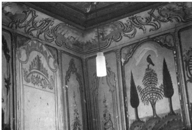
Εικ. 14. Μονή Προδρόμου Σερρών. Αρχονταρίκι. Άποψη νότιου και δυτικού τοίχου.
