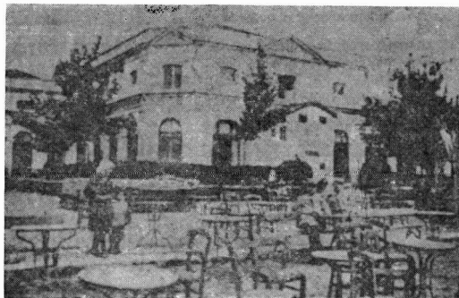
Εικ. 4. Το θέατρο του Λευκού Πύργου από τη ΝΑ πλευρά.
