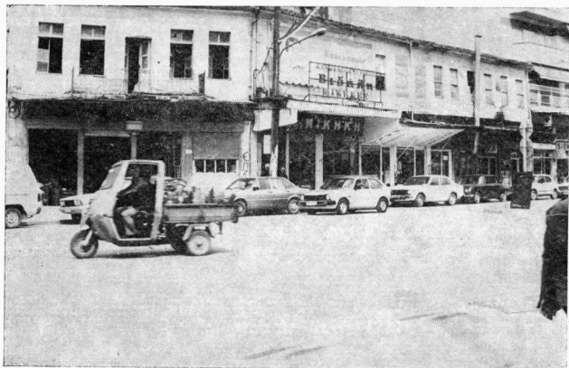
Εικ. 18. Σέρρες. Πλατεία Εμπορίου. Χάνι τον Ηλιάδη (το μικρό). Όψη προς την πλατεία, Απρίλιος 1984.
