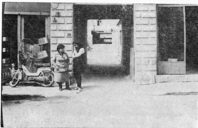
Εικ. 19. Σέρρες. Οδός Τρωάδος, αριθμός 5. Στοά εισόδου του πρώην χανιού του Τρωάκου (σήμερα σταθμός αυτοκινήτων), Απρίλιος 1984.
