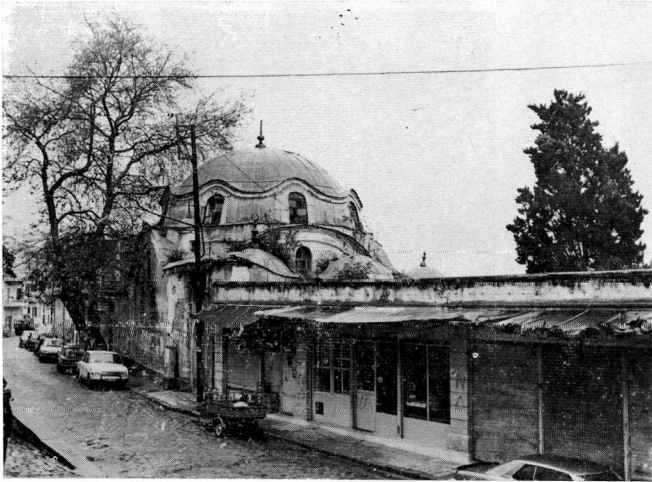
α. Δεύτερος μεντρεσές. Ἡ ἀνατολική ὄψη μετὸ κώγιο dershane καὶ τὰ μεταγενέστερα καταστήματα ἀπὸ τὴν ὁδὸ Πουλίδου
