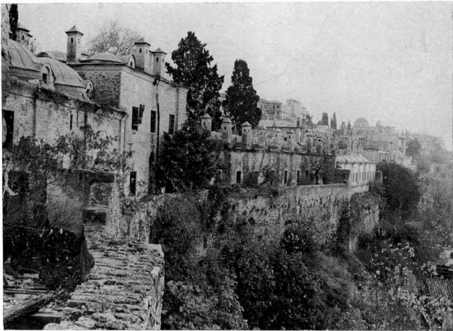
β. Γενική άποψη τοῦ Külliye. Ἀντικὴ ὄψη
