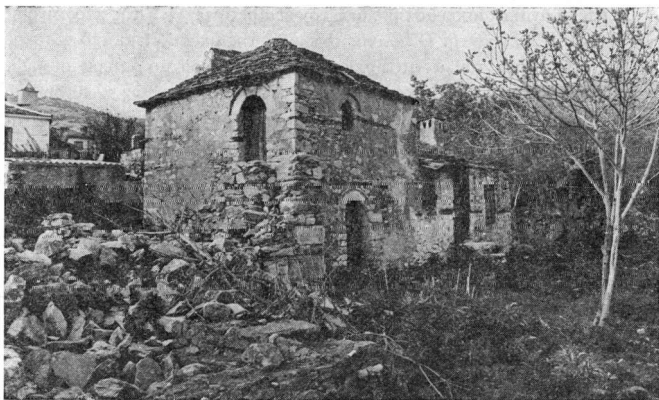
Εἰκ. 5. Νοτιοδυτικὴ ἄποψη τοῦ «Ἁγίου Μόδεστου».
