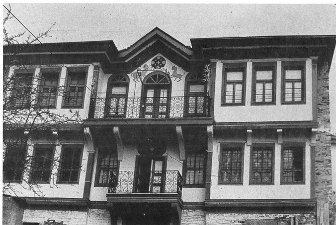
Εικ. 36. Κρούσοβο: παραδοσιακό σπίτι με στοιχεία εκλεκτικισμού (φωτ. του συγγραφέα, 1988).
