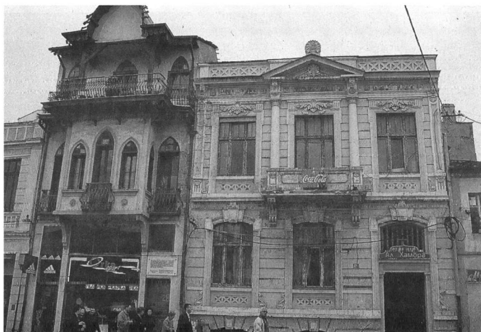
Εικ. 34. Μοναστήρι: νεοκλασικό κτίριο (φωτ. του συγγραφέα, 1999).
