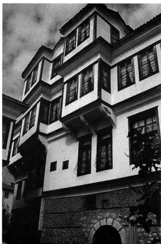
Εικ. 16. Αχρίδα: άποψη του αρχοντικού Ρόμπη. Διακρίνονται τα επάλληλα σαχνισιά της νότιας πτέρυγας του κτιρίου (φωτ. του συγγραφέα, 1999).
