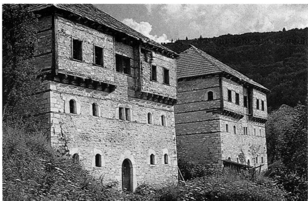
Εικ. 3. Μαύροβο, περιοχή Μιάκων (Mijaci): πυργόσπιτα με αρχιτεκτονική προεξοχή (πηγή: D. St. Pavlonić, «Γιουγκοσλαβία», Βαλκανική Παραδοσιακή Αρχιτεκτονική, εκδ. Μέλισσα, Αθήνα 1993, σ. 202).
