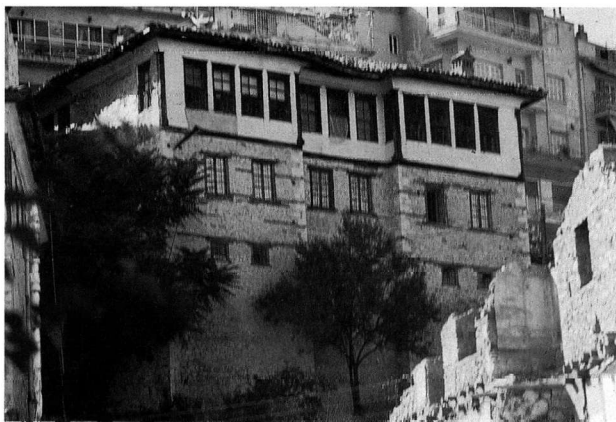
Εικ. 6. Καστοριά, νότια παραλία: τριώροφο σπίτι με πυργοειδή διαμόρφωση χωρίς σαχνισί (φωτ. του συγγραφέα, 1995).
