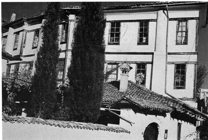
Εικ. 27. Αχρίδα: κτίριο στον Αγ. Νικόλαο Γηροκομείου (φωτ. του συγγραφέα, 1986).
