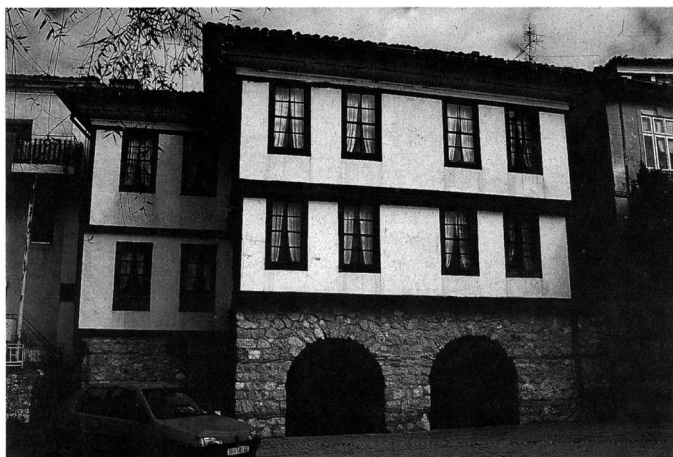
Εικ. 24. Αχρίδα: πέτρινοι πεσσοί που συνδέονται με τόξα (φωτ. του συγγραφέα,
