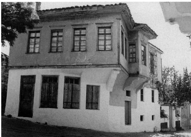
Εικ. 12. Βελβεντό Κοζάνης: σπίτι με τριγωνικό σαχνισί, η προβολή του οποίου στο έδαφος σχηματίζει γωνία με την οικοδομική γραμμή (φωτ. του συγγραφέα, 1987).
