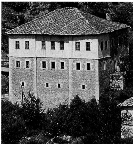
Εικ. 5. Γκαλισίνι, περιοχή Μιάκων (Mijaci): τριώροφο πυργόσπιτο χωρίς σαχνισί (πηγή: D. St. Ρανιονιέ, «Γιουγκοσλαβία», Βαλκανική Παραδοσιακή Αρχιτεκτονική, εκδ. Μέλισσα, Αθήνα 1993, σ. 203).
