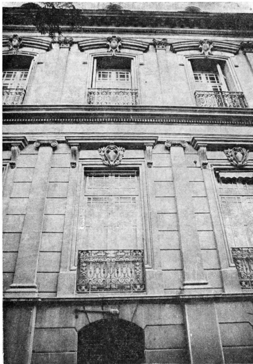
Photo 15. Détail de la façade latérale.
