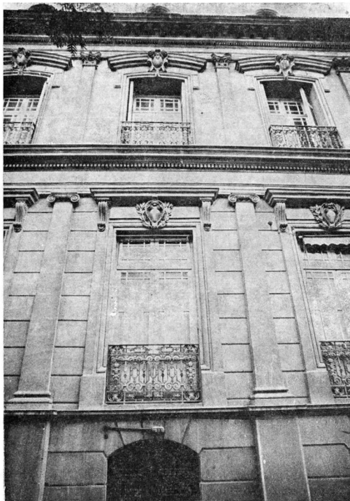
Photo 15. Détail de la façade latérale.
