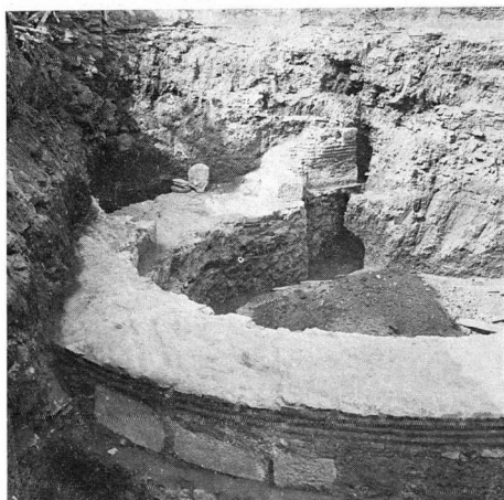
β. Ἡ ἀψίδα τοῦ ὀκταγώνου ἀπὸ βορρά. Διακρίνεται ἡ τοιχοδομία τοῦ κτιρίου καὶ ἡ ὑποθεμελίωσή του.
