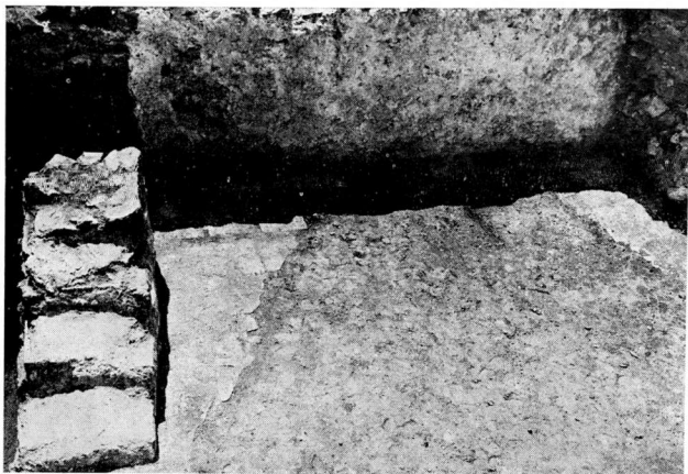
α. Τὸ δάπεδο καὶ ἡ κλίμακα τοῦ ρωμαϊκοῦ σπιτιοῦ. Στὸ κέντρο ἡ θεμελίωση τοῦ στυλοβάτη τοῦ ὀκταγώνου, τμῆμα τῆς ὁποίας ἐπιχρίσθηκε μὲ ἀσβέστη σὲ μεταγενέστερη ἐποχή.
