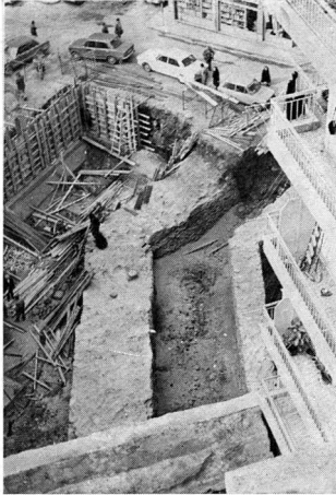
α. Οί θεμελιώσεις τοῦ ἐξωτερικοῦ τοίχου καὶ τοῦ στυλοβάτη τοῦ ὀκταγώνου, ὅπως βρέθηκαν στὰ θεμέλια οἰκοδομῆς τῶν ὁδῶν Μαβίλη καὶ Πηγριοῦ. Στὸν ἐξωτερικὸ τοῖχο διακρίνεται ὀκταγωνικὸ κορινθιακὸ κιονόκρανο.
