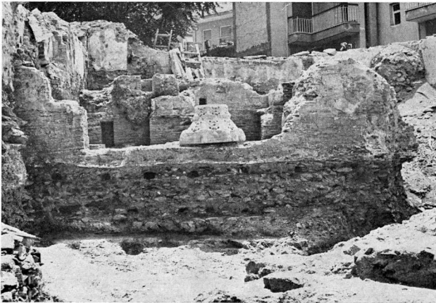
β. Ἀποψη τοῦ τουρκικοῦ λουτροῦ ποὺ διατηρεῖται στὸν ἀτάλαπτο χῶρο οἰκοδομῆς τῆς ὁδοῦ Πηγριοῦ 8. Στὸ κέντρο τὸ κορινθιακὸ κιονόκρανο, ὅπως βρέθηκε μετὰ τὴν κατεδάφιση τῶν παλιῶν κτισμάτων.
