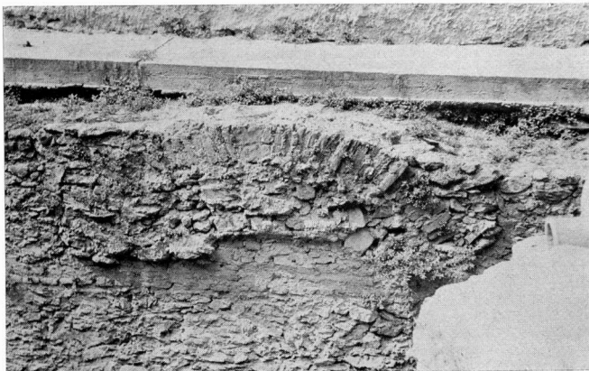
α. Τὸ ἀνακουφιστικὸ τόξο στὸ νότιο στλοβάτη τοῦ κεντρικοῦ κλίτους τοῦ ναοῦ Α
