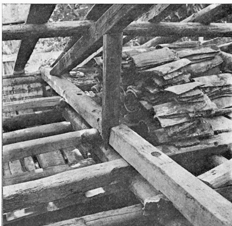
Εἰκ. 5. Ἐντομίες στὶς θέσεις στηρίξεως τῶν στύλων τοῦ β' ὀρόφου
