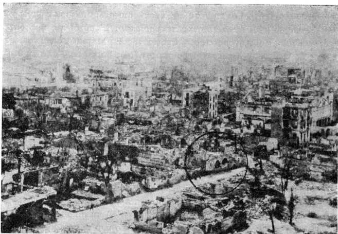
Εικ. 2. Ἡ καμένη περιοχή βόρεια ἀπὸ τὸ ναὸ τοῦ ἁγίου Νικολάου Τραπεζοῦ. Ἀριστερὰ φαίνεται μέρος τῆς Ἀχειροποιήτου καὶ ὁ μυναρὲς τῆς. Διακρίνεται τὸ κτίσμα μὲ τις δύο καμάρες στὴν πρόσοψη
