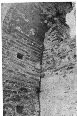
Εικ. 23. Λεπτομέρεια τῆς δυτικῆς πύλης τοῦ λιμένα, ποὺ φράχθηκε ἀπὸ τὸ Φρούριο Βαρδαρίου
