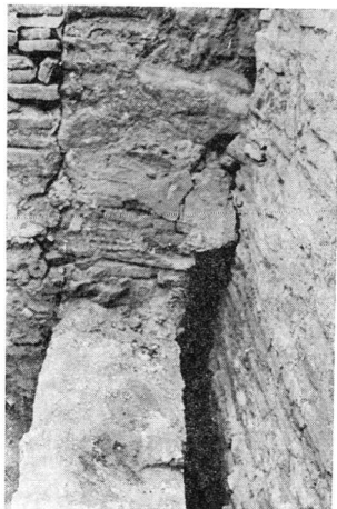
Εἰκ. 17. Ὁ ἀρχικὸς ἀνατολικὸς τοί- χος τοῦ πύργου Ἀναγλύφου (ἀριστε- ρὰ), ὅπου ἀποκαλύφθηκε ἡ ἐντοιχι- σμένη ἐπιγραφή καὶ ὁ δεῦτερος ἐνι- σχυτικὸς τοίχος (δεξιὰ) ποὺ κατα- σκευάσθηκε ἀργότερα
