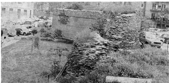
Είκ. 1. Τμήμα τοῦ δυτικοῦ τείχους τῆς Θεσσαλονίκης, ἐνσωματωμένο στο Φρούριο Βαρδαρίου. Διακρίνεται ἡ τοιχοδομία του με ἀποκλειστική χρήση πλίνθων
