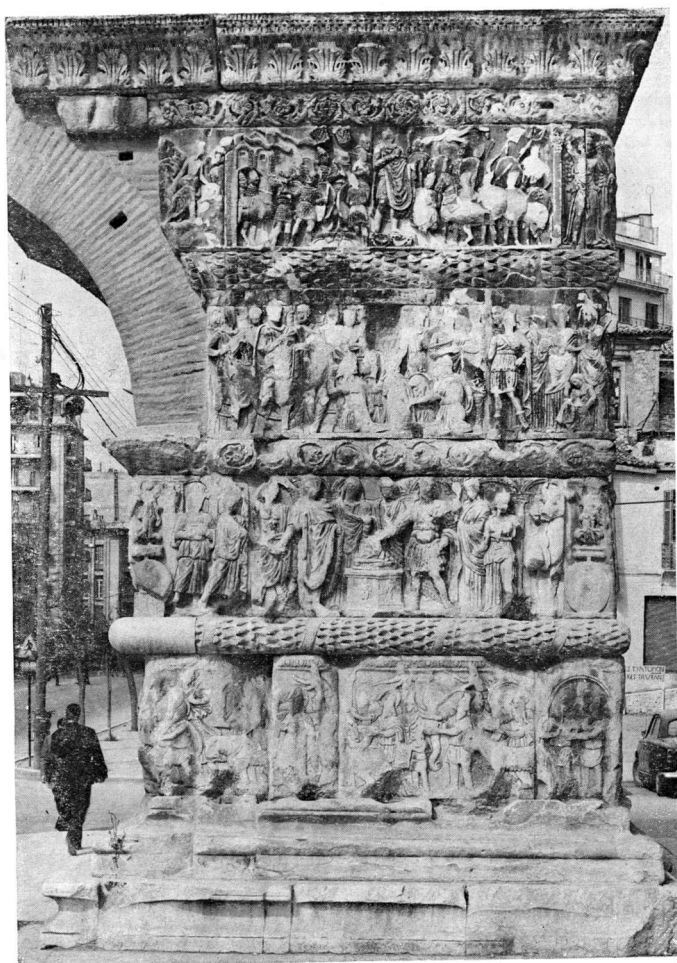
Δυτικός πεσσός, ΝΑ πλευρά: ζώνες υπ' αριθ. 15 και 24-26 (54)
