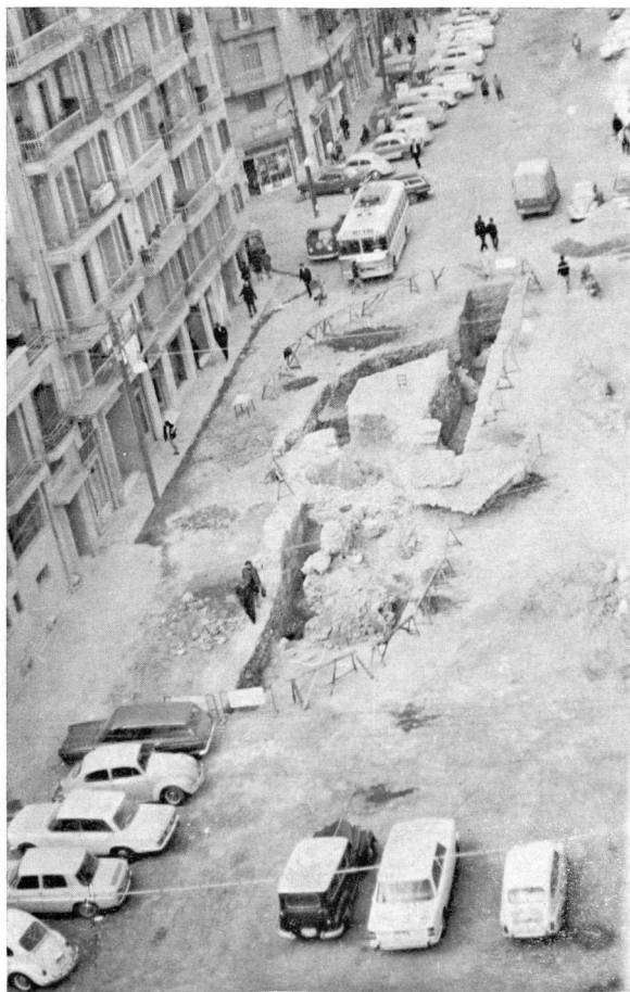
Ὁδὸς Δημ. Γούναρη: Ἐκσκαφὴ ἀπὸ Ν, ἀπὸ τὴν πολυκατοικία τοῦ Ταμείου Προνοίας Δικηγόρων Θεσσαλονίκης (54)ῃ
