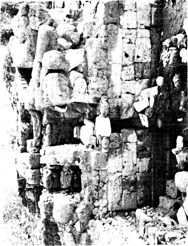
Από το εσωτερικό της πόλεως άποψη του βάσιου πύργου της Ν.Α. πύλης (90)
