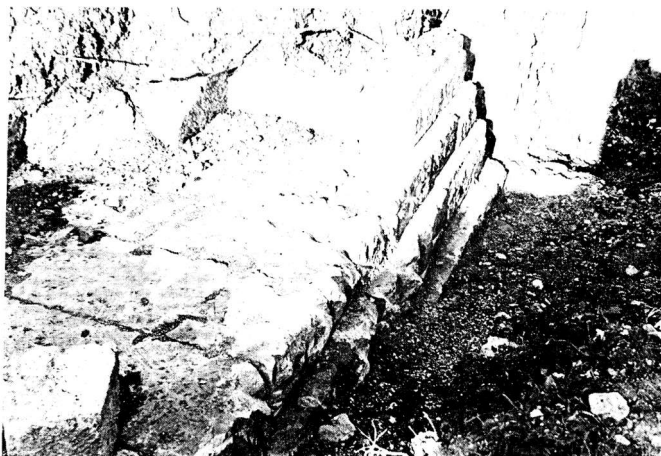
Από ΝΑ άποψη τής ΝΑ γωνίας τοῦ ναοῦ, ὅπως τήν ἄφησε ὁ μηχανικοῦς ἐκσκαφεῶς (φωτ. 3.2.69) (126)
