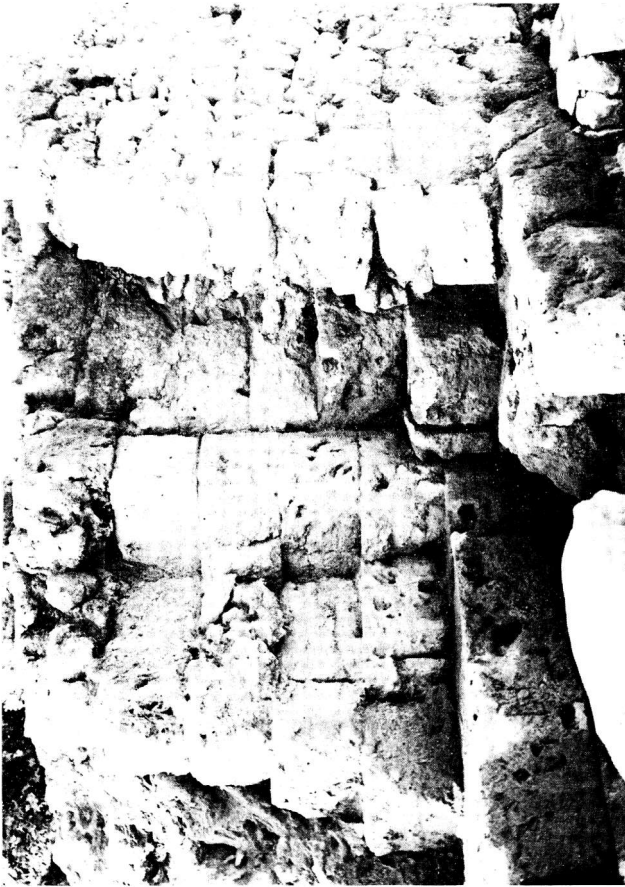
Λείψανα τῆς ἰσοδομικῆς κατασκευῆς τῆς ἀρχαίας πόλεως καὶ ἡ μεταγενέστερη ἐπέκτασή (δεξιὰ), ποβλ. πίν. 114, ἀριστερὰ (90)
