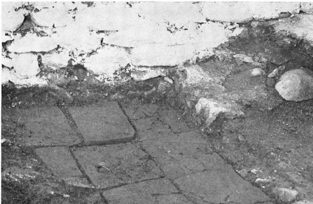
γ. Ἐνωση τοῦ βορείου στυλοβάτη μετὰ τὸν ἀνατολικὸ τοῖχο τῆς βασιλικῆς τῆς Ἁγίας Μαρίνας
