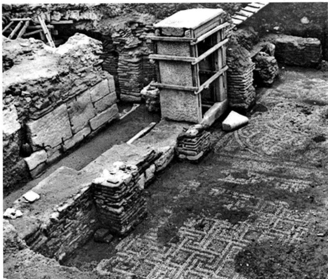
Εικ. 12 . Θεσσαλονίκη 1963. Ανασκαφή πλατείας Δικαστηρίων. Ωδείο. Πύλη και ψηφιδωτό δάπεδο.
