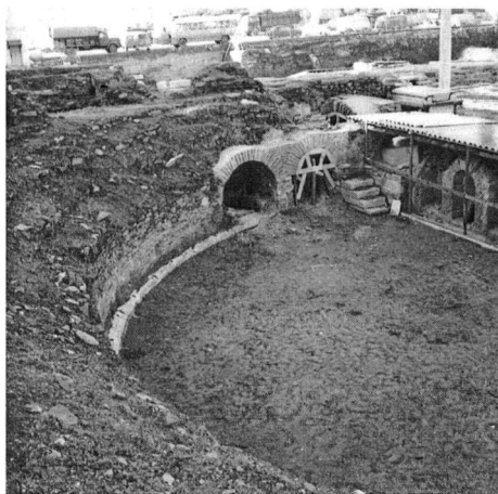
Εικ. 25. Η κατάσταση των κερκίδων του Ωδείου.
