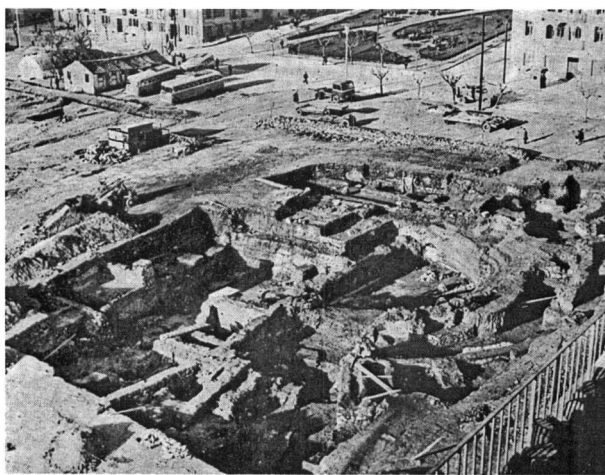
Εικ. 21. Η αποκάλυψη της επάνω επιφάνειας του Ωδείου.
