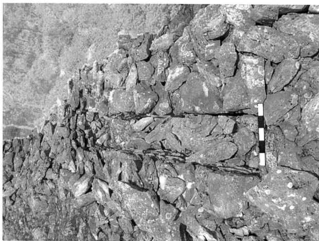
Εικ. 6. Μεγάλο Κασπρί. Ορθογώνια περιγοειδής κατασκευή στον βορειοανατολικό τμήμα του τείχους στο βόρειο λόφο.
