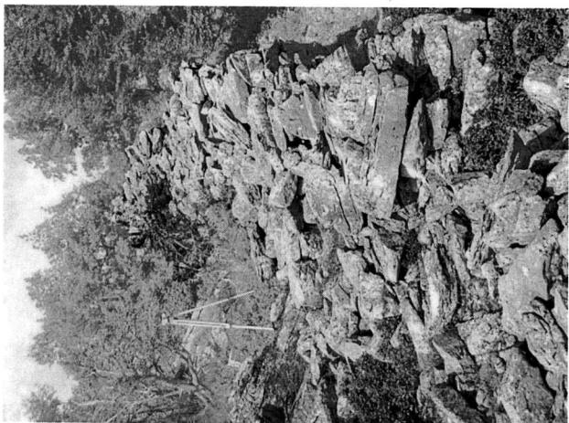
Εικ. 5. Μεγάλο Κασπρί. Τμήμα του τείχους στον βόρειο λόφο.
