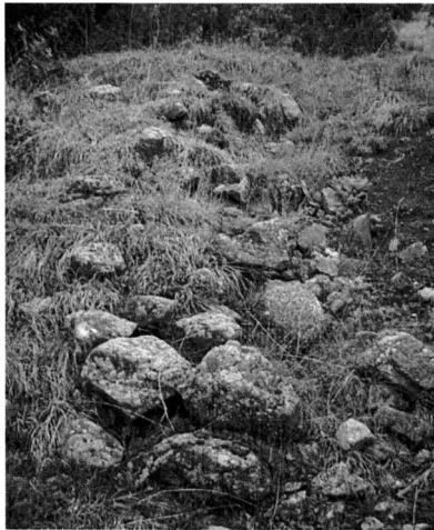
Εικ. 16. Κακόπετρες. Αποψη τμήματος τείχους οχύρωσης.
