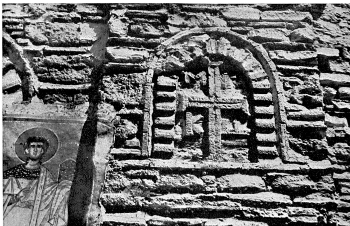
α. Τμήμα τῆς νοτίας πλευρᾶς
