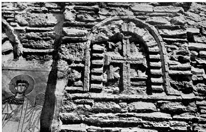
α. Τμήμα τῆς νοτίας πλευρᾶς
