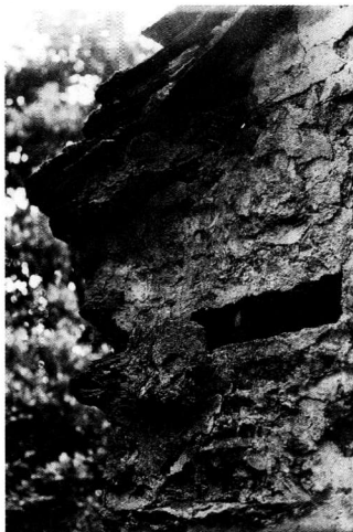
Εικ. 5. Άποψη του γείσου του ναού.
