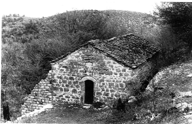
Abb. 1. Außenansicht von Südwesten.
