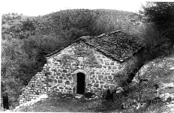
Abb. 1. Außenansicht von Südwesten.
