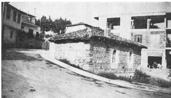
Fig. 11. La maison d'Asvestohori vue du NE
