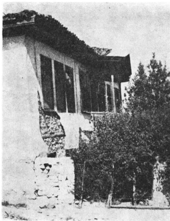
Εἰκ. 5. Τὸ μητροπολιτικὸ κτήριο ὅπως εἶναι σήμερα.
