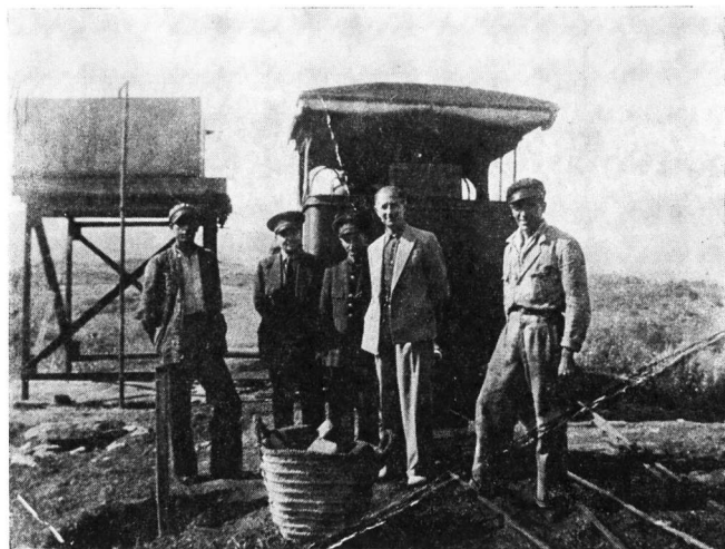
Εικ. 1. Αναμνηστική φωτογραφία σιδηροδρομικών με φόντο τη μηχανή 952 του αμερικανικού εργοστασίου BALDWIN.
