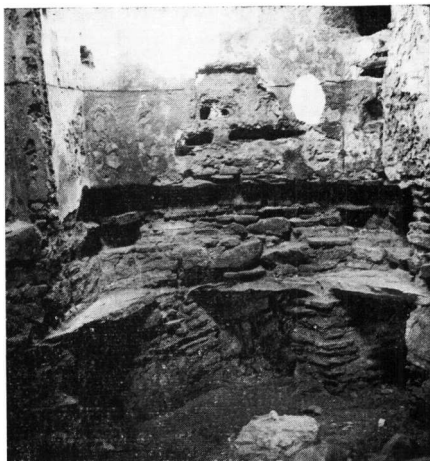
α. Το κάτω μέρος της κατασκευής του ζεστού χώρου. Φαίνονται: οι σωλήνες ζεστού και κρύου νερού, τα κανάλια του ζεστού αέρα, τα σημεία στήριξης του δαπέδου, τα υπόκαυστα.
