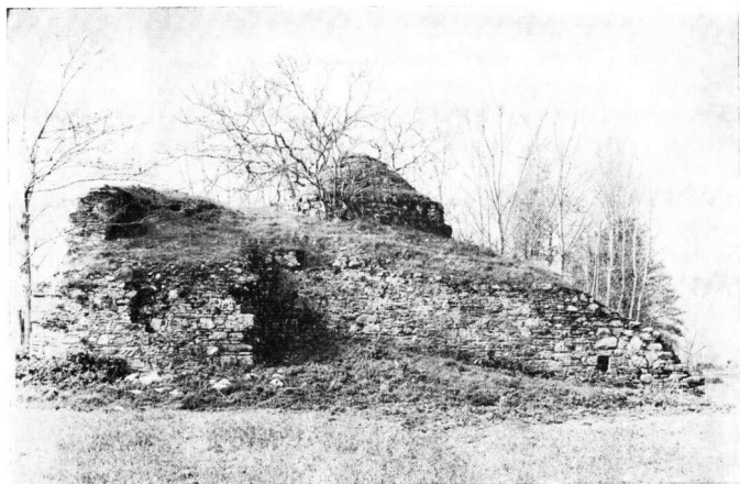
β. Η ανατολική πλευρά πριν τον καθαρισμό.
